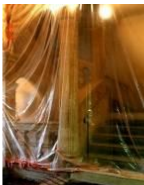
Photo du chantier de restructuration Dominique DELPOUX
