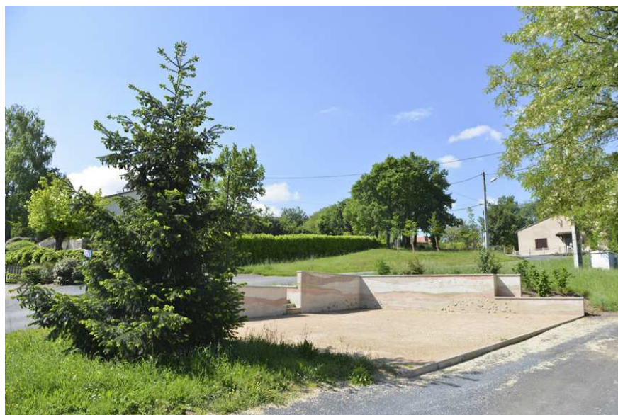
placette du Peyroulié rénovée
